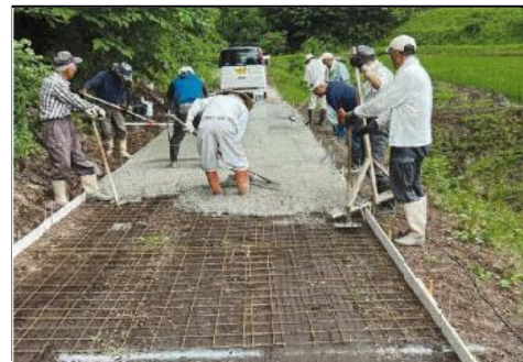
【農道の舗装作業】
