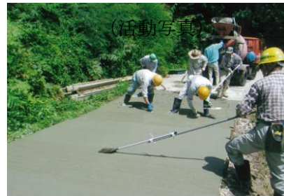
【生コン打設状況】
