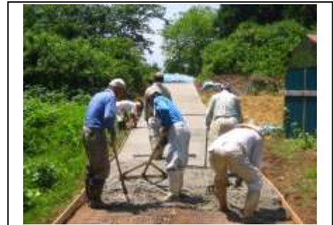
【住民による舗装作業の状況】
