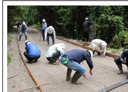
【農道舗装の様子】
