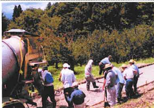
(前坂地区での作業の様子)
