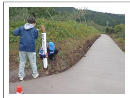
(佐野地区での作業の様子)
