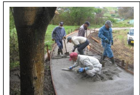
【農道舗装の様子】
