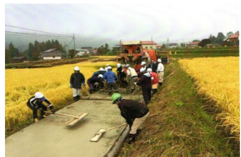
【農道の舗装作業】
