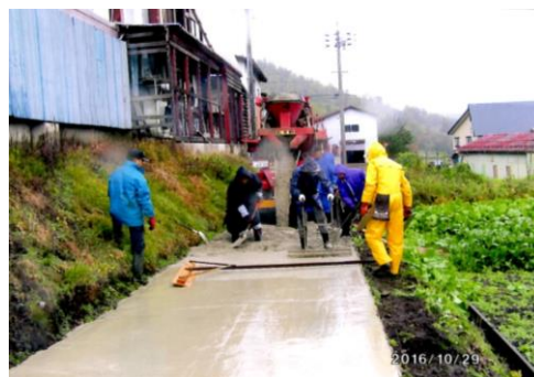
【農道の舗装作業】
