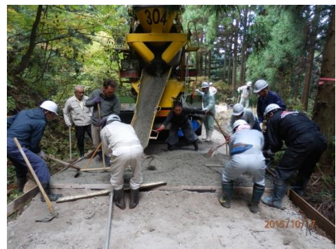
【農道舗装の様子】
