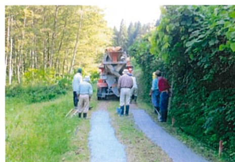
【生コン打設状況】
