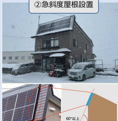
②急斜度屋根設置
