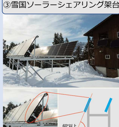
③雪国ソーラーシェアリング架台
