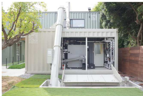
130kW級バイオマスボイラーユニット (ボイラー庫、チップ庫が一体型)
