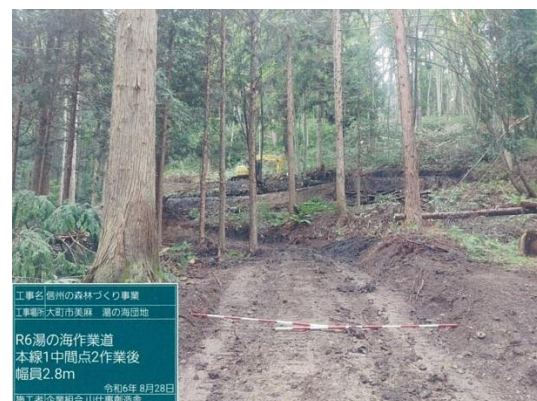
大町市 湯の海（作業道）
