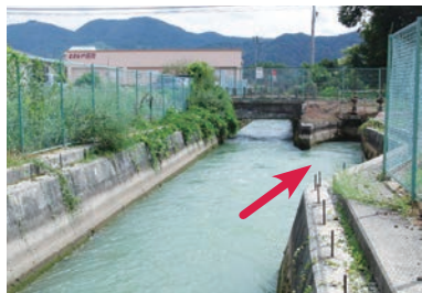
須沼板取分水（導水路から須沼板取用水路へ水を分ける）
