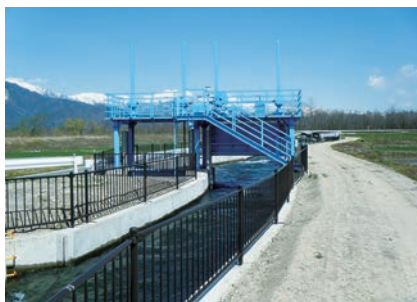
町川にある水門（大雨の時、左の水門で高瀬川へ流す）
