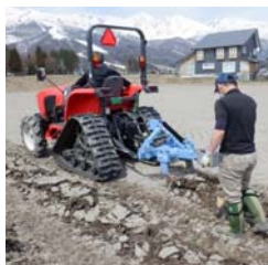
カットブレイカーによる排水対策
