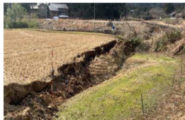
農地の地割れ（珠州市）
