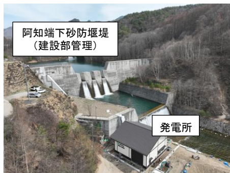
阿知端下砂防堰堤と金峰山川発電所
