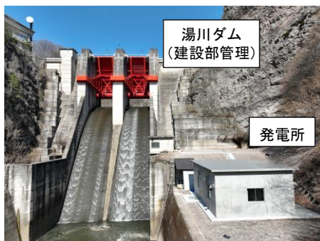
湯川ダムと森泉湯川発電所
