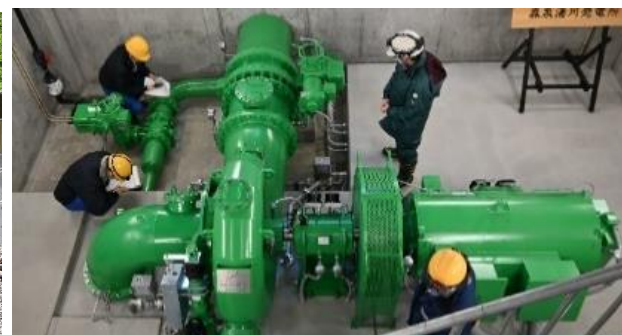
水車発電機の試運転状況
