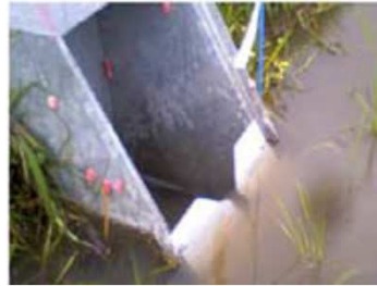
水田排水口の調整施設 設置例
