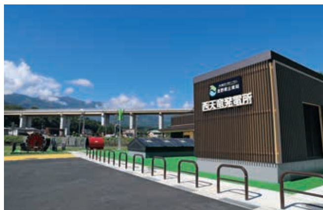
西天竜発電所（伊那市）
