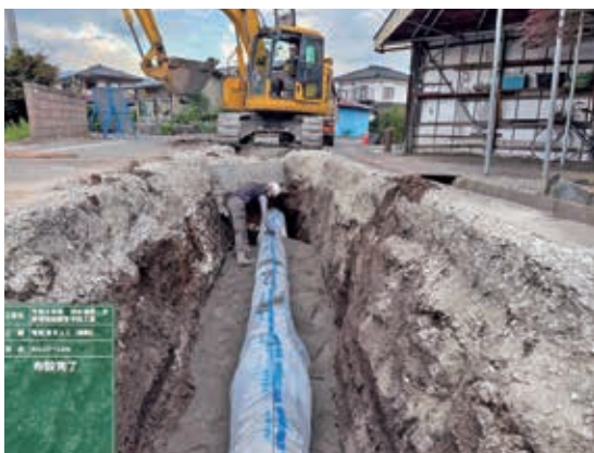
送水管の布設工事（塩尻市宗賀地区）
