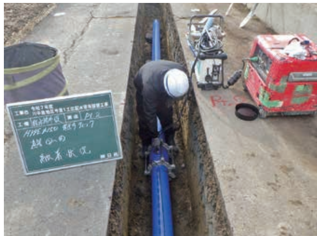
配水管の布設替工事（長野市今里地区）
