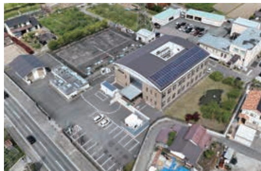
四ツ屋浄水場(長野市)
