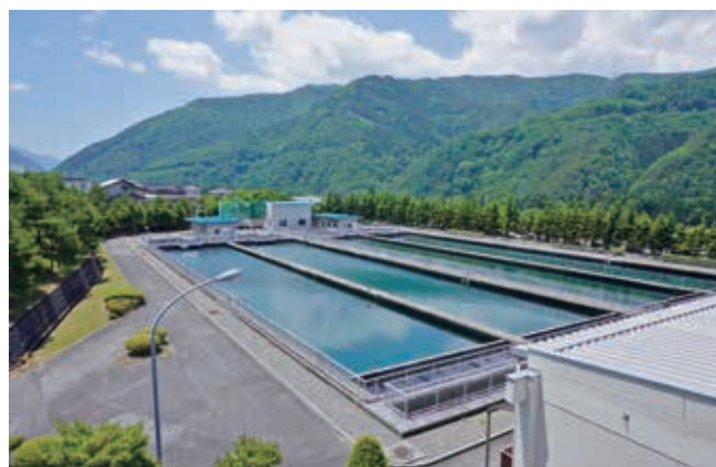
本山浄水場（塩尻市）
