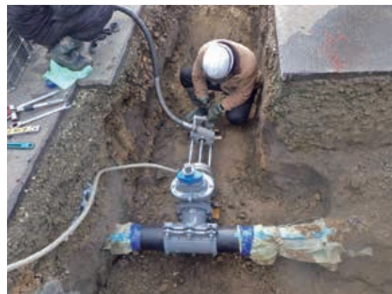
老朽管工事 (長野市今里地区)
