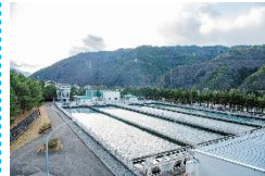
←耐震化工事を実施中の本山浄水場(塩尻市)
