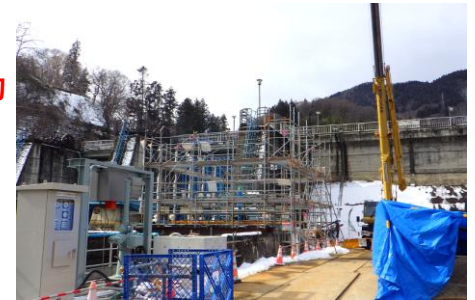
建設中の「湯の瀬いとおしき発電所」
