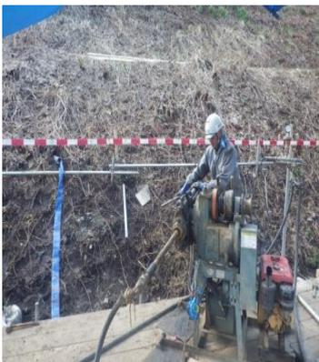
当現場の地すべり対策工の一つである横ボーリング工です。地すべりは地下水位が高いと発生しやすいため、この場所から放射状に水を抜くための横ボーリングを施工し、地下水を排水して地下水位を低下させます。
