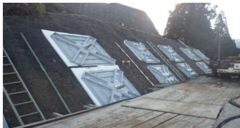
当現場の地すべり対策工の一つであるアンカー工です。地すべりブロックをアンカーで支持地盤に固定し、地すべりの滑動を止めます。
