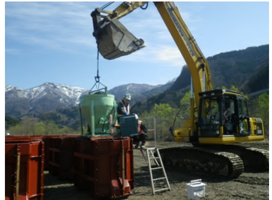
コンクリート打設状況
