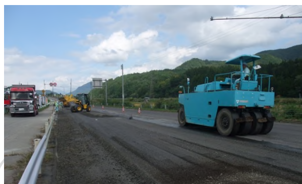
タイヤローラーによる締め固めの様子
