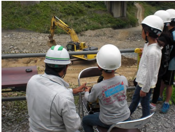
重機のラジコン操作体験(金山沢工事用道路工事)
