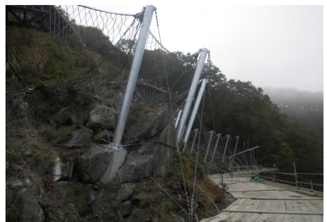
工事施工中の様子
