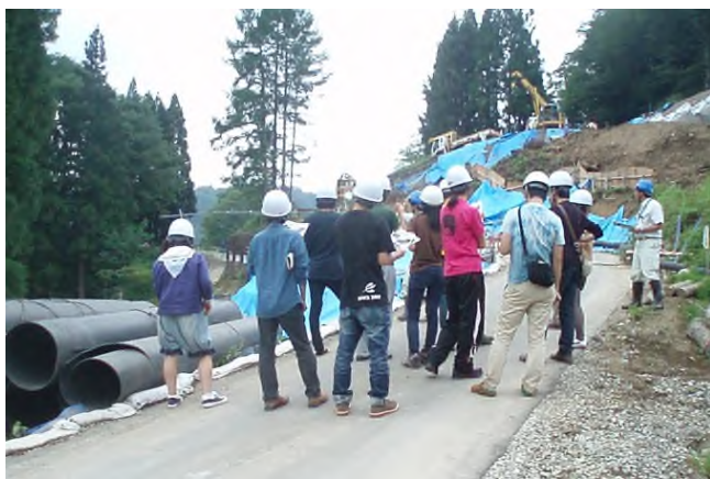
地すべり災害清水山現場視察
