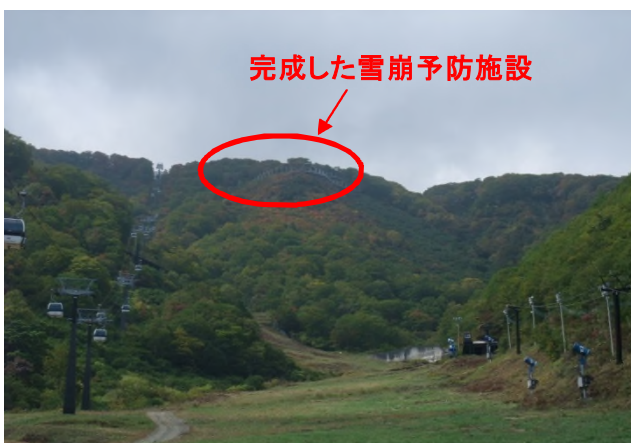
五竜スキー場グレンデから施設を見る
