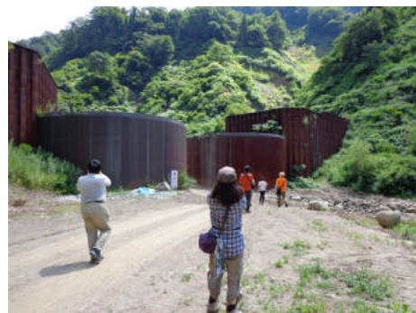
土谷川 セル堰堤 巨大な円柱で土石流を止めます
