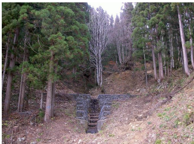
着工前 (平成27年11月)
