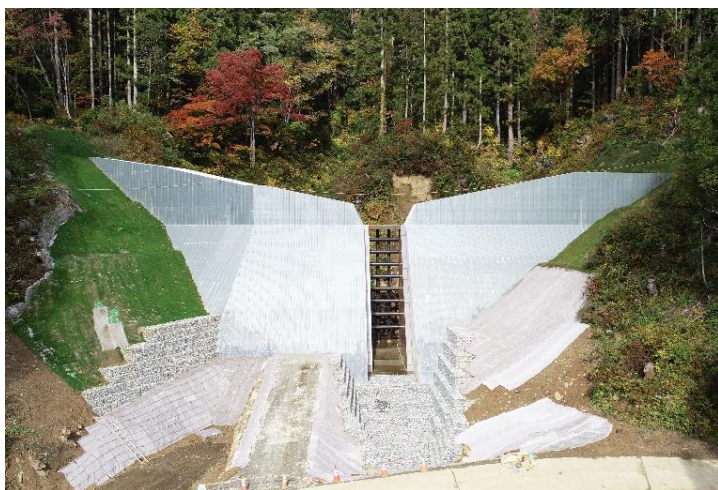
完成 (平成30年12月)
