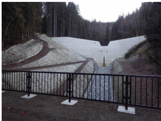
完成 (平成30年12月)
