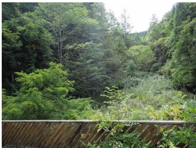
着工前 (平成28年9月)
