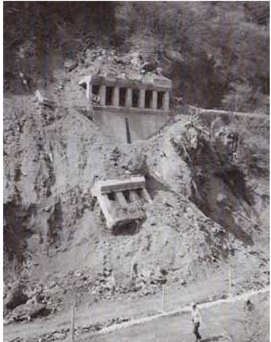
山腹大崩落による猿なぎ洞門崩壊状況 平成3年10月（『峠の道路史』より転載）
