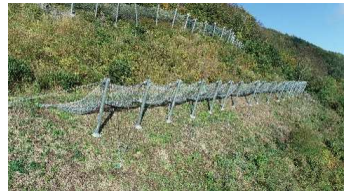
雪崩予防柵(R8.1月竣工)
