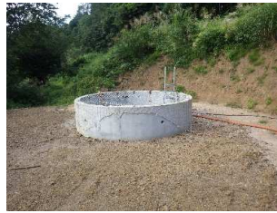
完成した集水井
