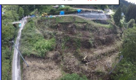
アンカー工施工前
