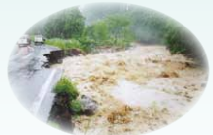
白馬村楠川護岸決壊と県道千国北城線
