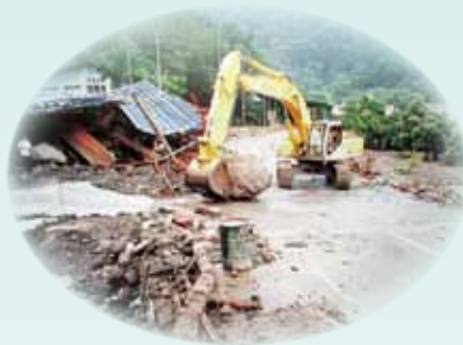
塩沢の土砂除去作業
