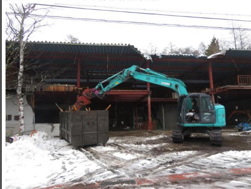
安全パトロール時の解体作業現場
