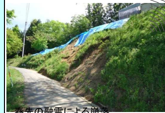
春先の融雪による崩落
