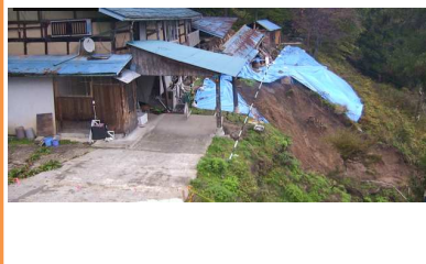
家屋の被災状況
