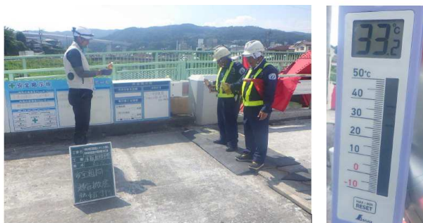
熱中症予防説明、温度計の設置
