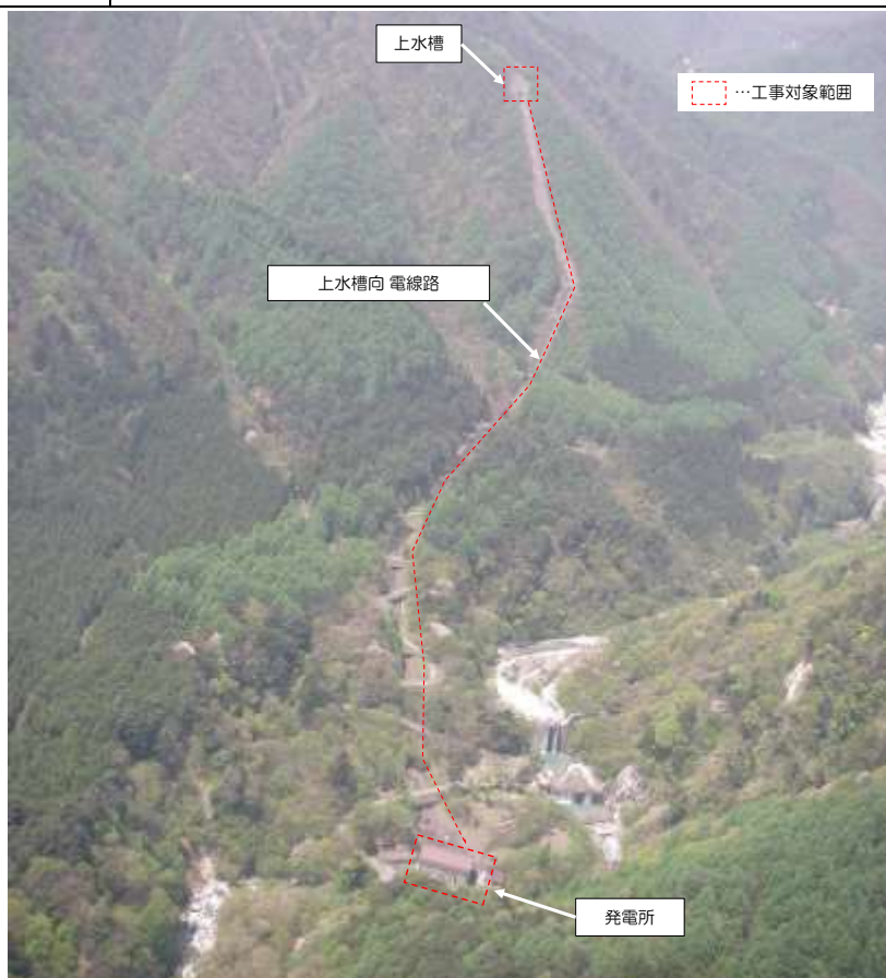
図-2.5 与田切発電所 工事対象施設
