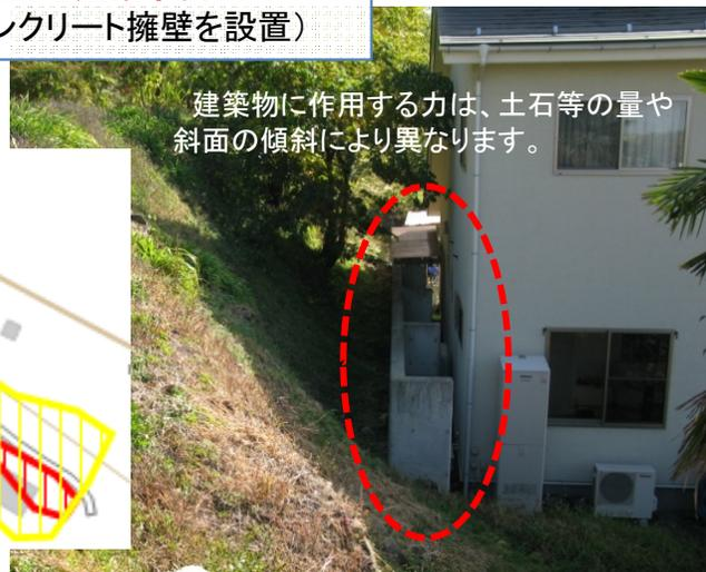
建築物に作用する力は、土石等の量や斜面の傾斜により異なります。
