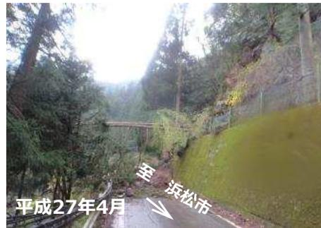
道幅が狭く、線形が悪いため、落石や法面崩落などの災害が頻発する道路でした
