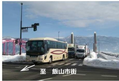
老朽橋である上、落雪により通行車を損傷させる事故が度々発生していました。
