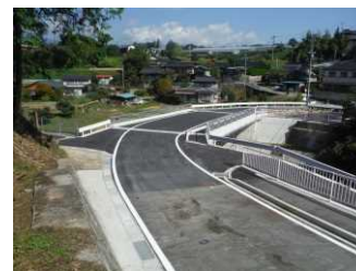
道路防災(橋梁架替)
