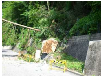
落石による全面通行止
