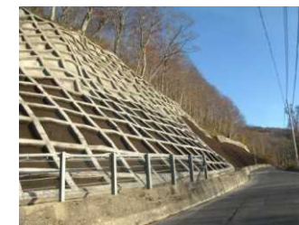
道路防災(法面对策)
