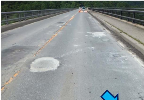
★床版の損傷により、橋面舗装にポットホールが発生！車両の安全・快適な通行に支障
