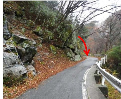
切り立った斜面から岩塊が張り出し、亀裂も確認され、いつ崩落するか不安…
