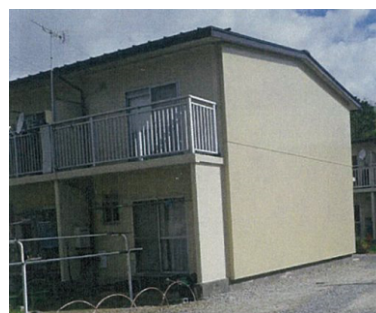
耐震化がされていない住宅
