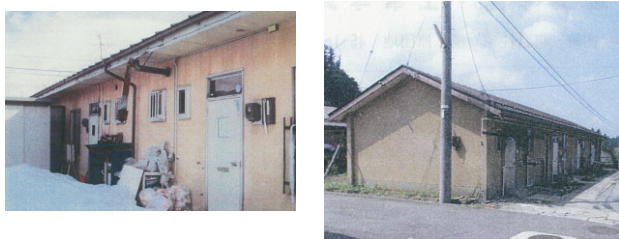
建築後40年以上が経過した公営住宅
