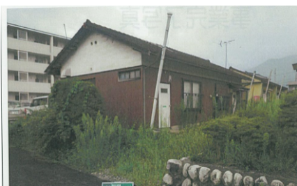
建築から時間が経過し、老朽化が進んでいる。耐震性も不安
