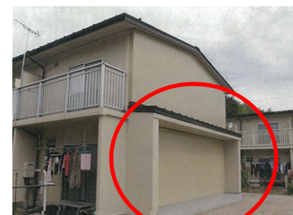
袖壁増設等の耐震補強を施し、耐震性を確保
