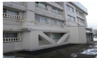
耐震補強を施した住宅
