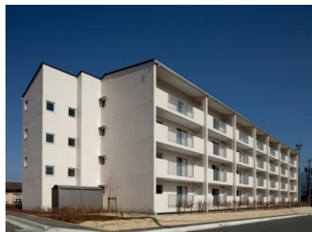
建替えにより、居住性、安全性ともに向上
