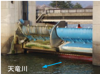
ゲートの劣化状況
