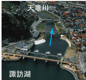
釜口水門全景
