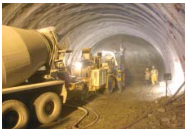
写真 - 3 二次吹付状況
