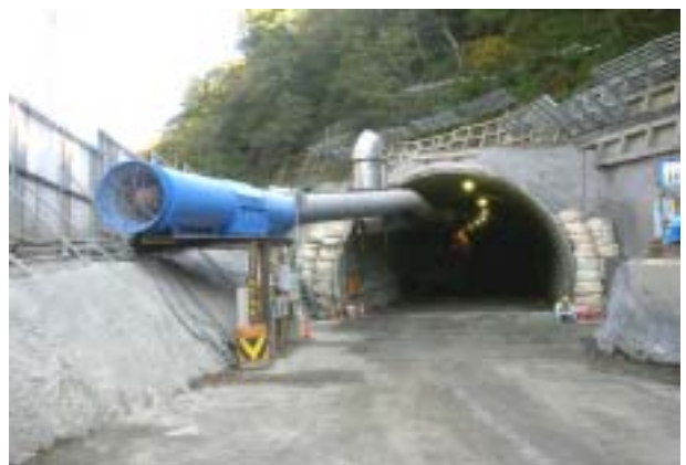
写真 - 7 送気ファン（1000m 3 /min）
