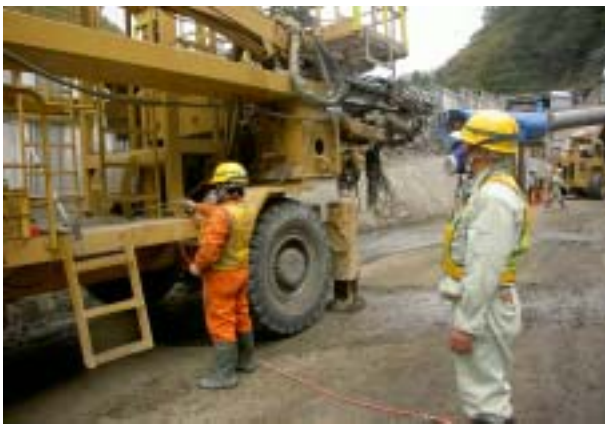
写真 - 5 堆積粉じん除去（トンネル機械）
