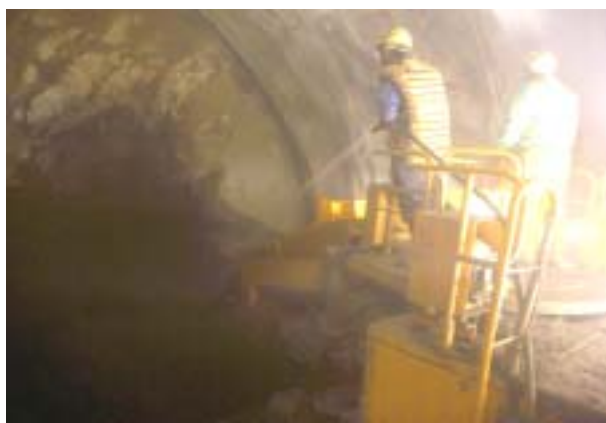
写真 - 2 機械掘削時散水状況
