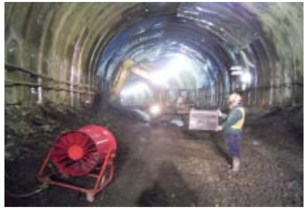
写真 - 10 局所ファンを使用したインバート掘削
