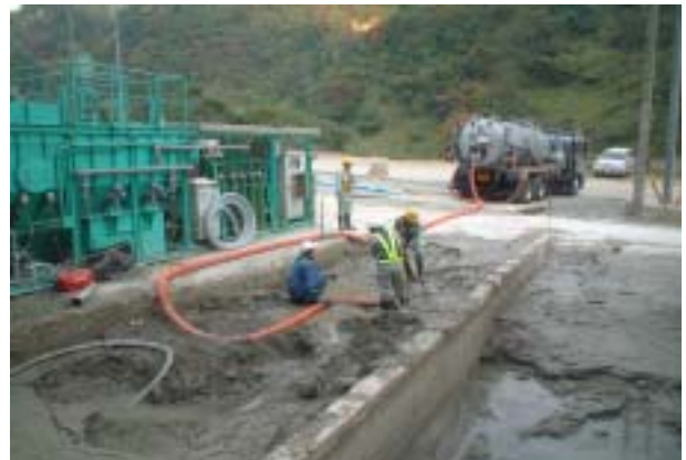
写真 - 14 濁水プラントの汚泥処理状況
