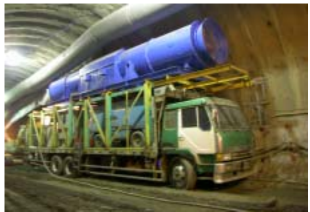
写真 - 6 排気ファン（2400m 3 /min）
