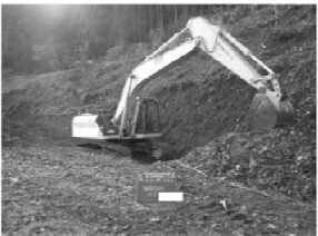
平板載荷試験の実施状況
