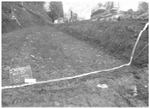
置換基礎の施工基面
