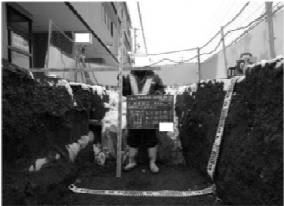
掘削断面内の埋設管状況
