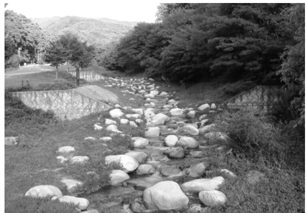
写真 9-4-14 分散型床固工の事例（鳥居川）
