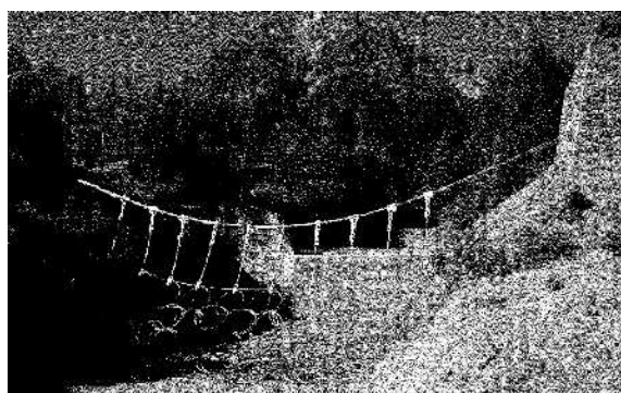
写真 9-4-10 強靱ワイヤネット砂防堰堤
