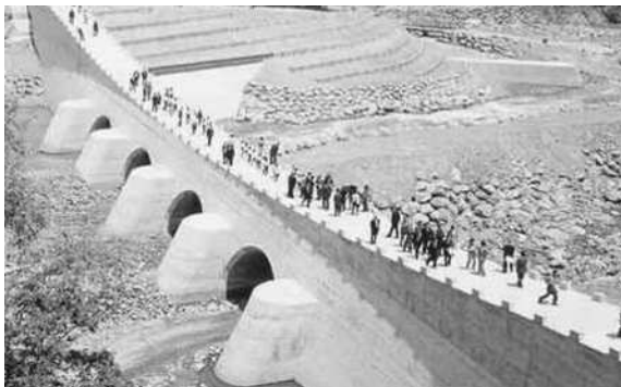
写真 9-4-3 大暗渠式(スーパー暗渠式)砂防堰堤
