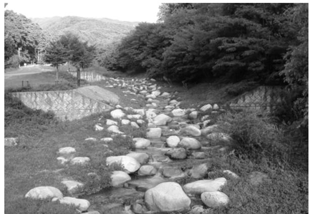
写真 9-4-14 分散型床固工の事例（鳥居川）
