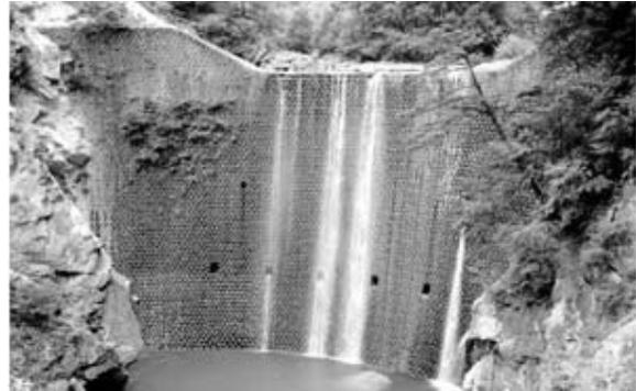
写真 9-4-5 アーチ式砂防堰堤
