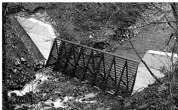
写真 9-4-8 バットレス型スクリーン式砂防堰堤
