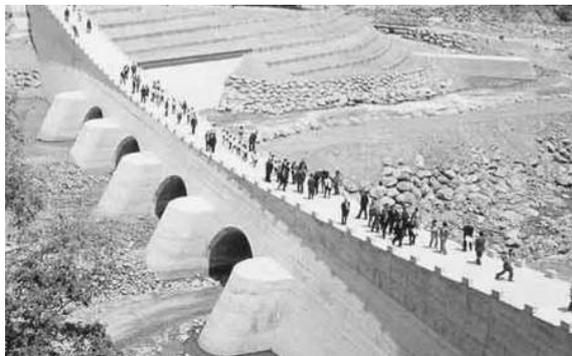
写真 9-4-3 大暗渠式(スーパー暗渠式)砂防堰堤
