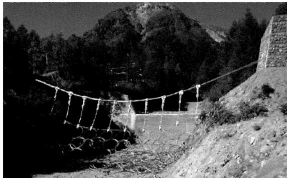
写真 9-4-10 強靱ワイヤネット砂防堰堤
