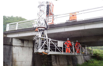
☆ 小型クローラ式 橋梁点検車による調査
