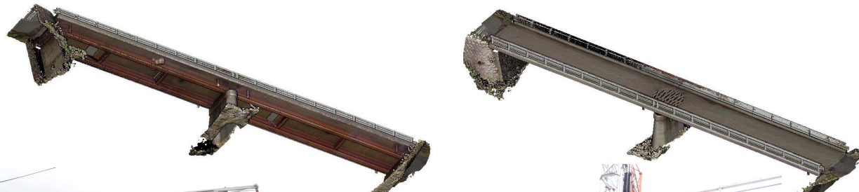
☆ 太郎別当橋 型式：2径間鋼単純H桁橋 橋長 L=36.060m 幅員 W=3.630m
