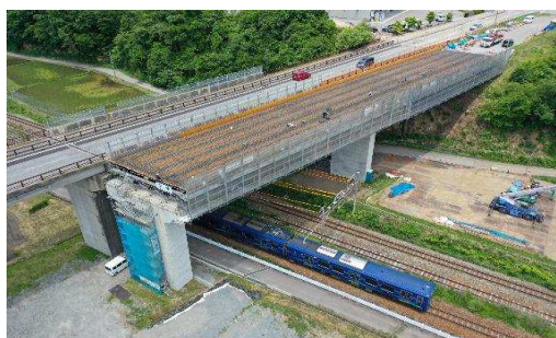
床版工施工状況
