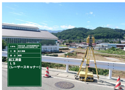
起工測量(レーザースキャナー)
