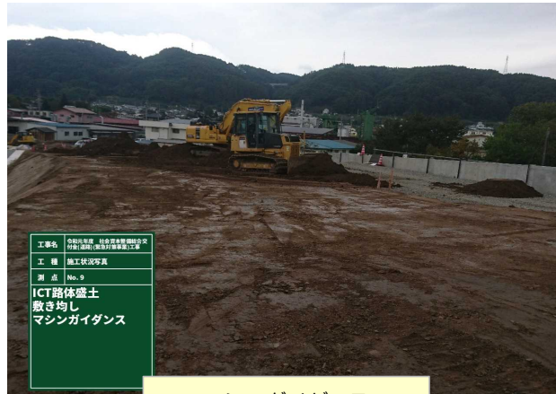
マシンガイダンス D3ブルドーザー敷均し
