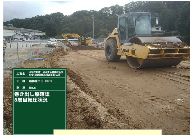
マシンガイダンス 10t振動ローラー転圧
