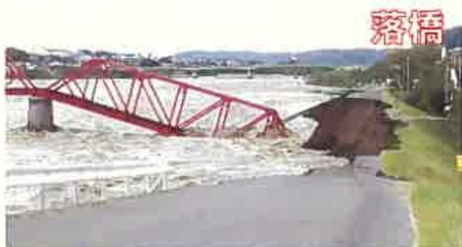
千曲川橋梁落橋により鉄道が寸断
