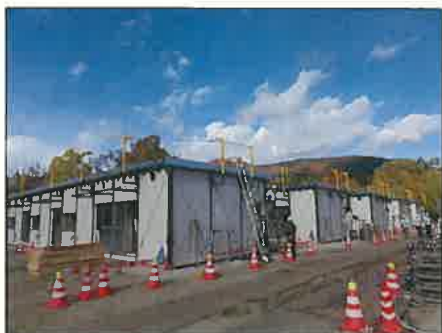
プレハブの応急仮設の設置状況
