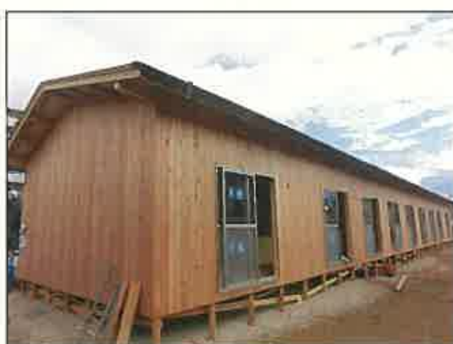
木造の応急仮設の設置状況
