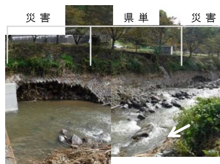
台風 19 号の洪水により護岸が崩壊した箇所において、次期出水時に被災する恐れのある脆弱な護岸を併せて復旧し、一連区間の防災強化を図ります。
