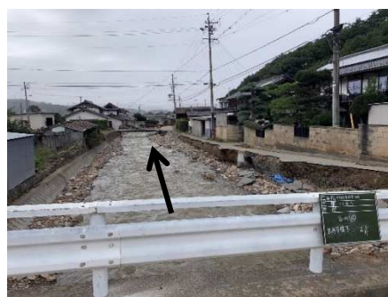
台風 19 号により護岸が欠壊したため、早期の対策により、護岸を復旧し、浸水被害の防止を図ります。
