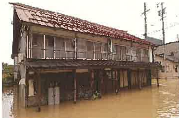
旅館浸水（外観）
