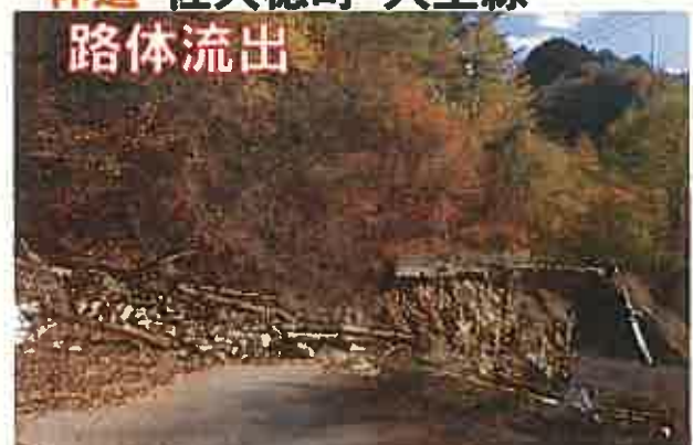
豪雨により路体が流出し通行不能
