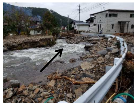
台風 19 号により河道が埋塞し、護岸も欠壊したため、未被災施設を含む一連区間の護岸を復旧し、再度災害の防止を図ります。
