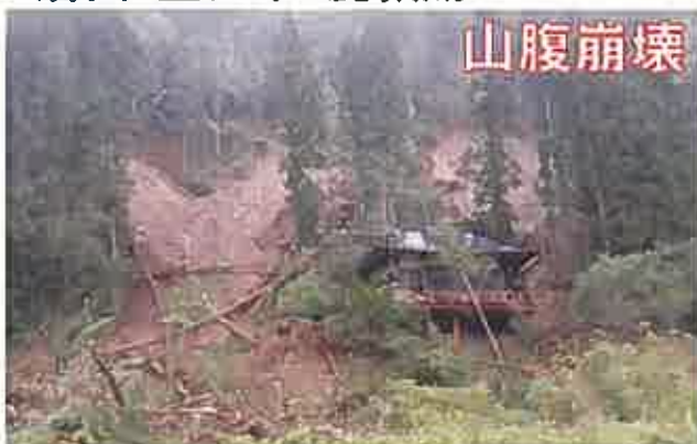
山腹崩壊により建物が被災
