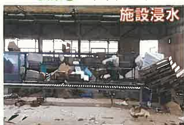
集出荷施設が浸水し稼働停止
