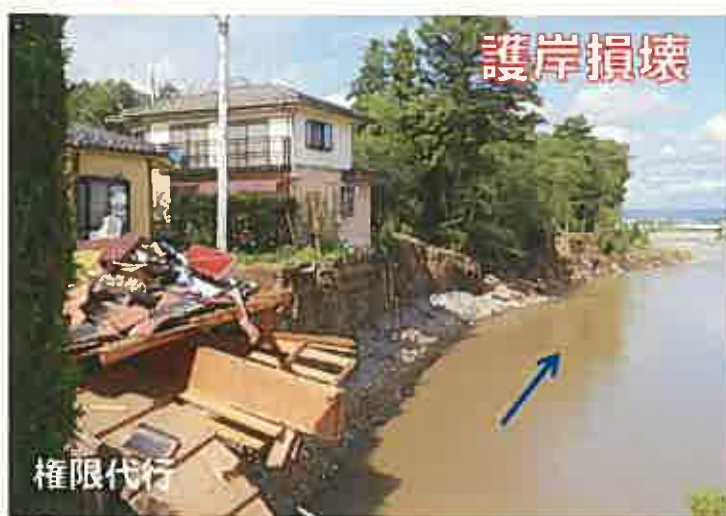
護岸浸食により人家倒壊
