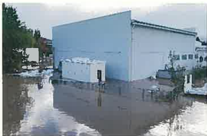
工場浸水（外観）
