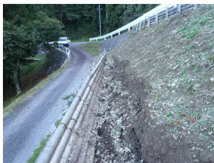
台風 19 号により法面が崩れ丸太柵が破損したため、復旧工事を行います。
