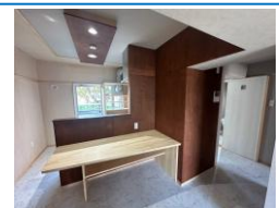
県営住宅“子育て住宅”リノベーション 対面キッチン・カウンターを配置(伊勢林団地:佐久市)
