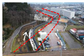
流域治水対策 (一)血川 飯山市 北町 (築堤、鉄道橋の架替え)
