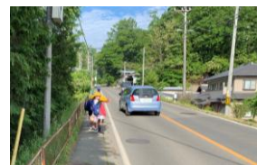
通学路等の交通安全対策推進 (主)駒ヶ根長谷線 駒ヶ根市 田沢 (歩道設置)
