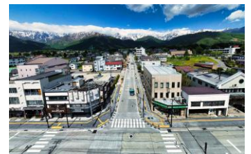
道路環境整備(無電柱化) (国)148号 白馬村 白馬駅前
