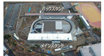
都市公園(陸上競技場の整備) 松本平広域公園陸上競技場
